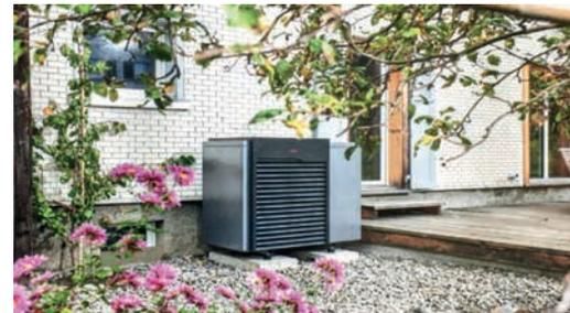
*Pompe à chaleur air-eau placée à l'extérieur du bâtiment. Le module visible en façade est constitué d'un ventilateur et de l'évaporateur de la machine thermique.*
