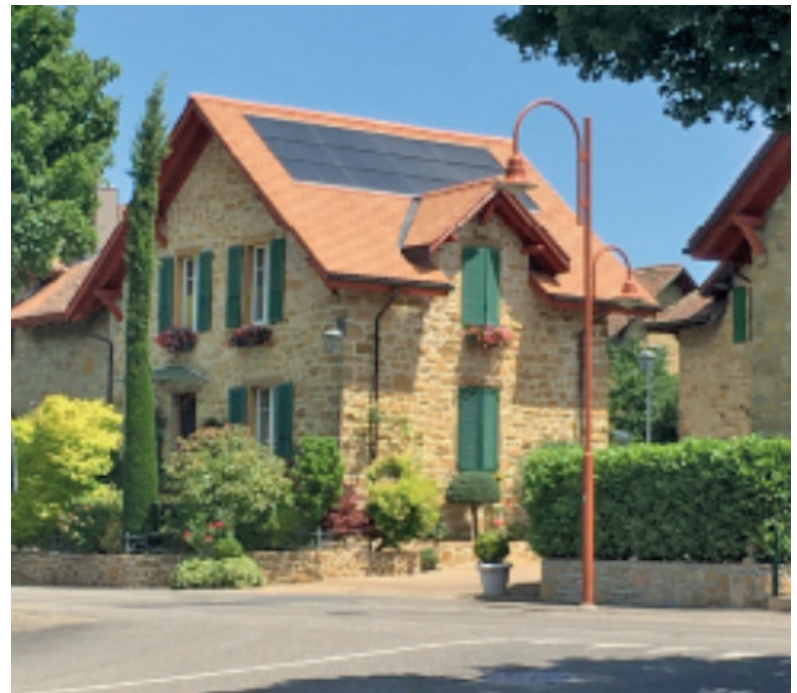
Exemple d'installation solaire photovoltaïque parfaitement intégrée sur un bâtiment protégé
