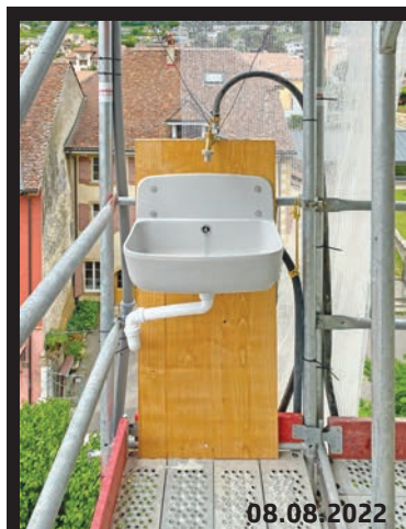
Le point d'eau installé sur l'échafaudage permet aux restauratrices de la pierre de nettoyer leur outillage. Ceci, tout en bénéficiant d'une vue remarquable sur l'ancien village de Saint-Blaise.
