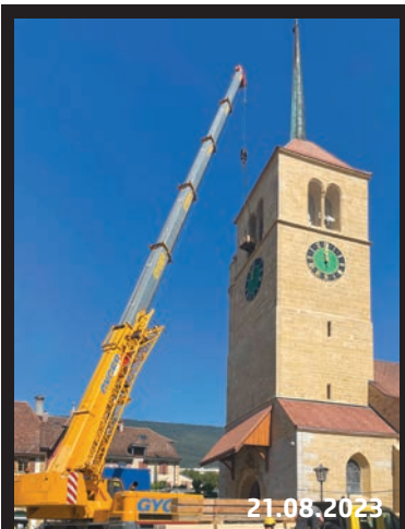
Le beffroi est livré et monté sur place. L'espace très exigu dans le clocher a demandé une planification ainsi qu'une exécution et une manutention de grande précision.
