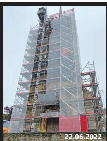
L'échafaudage, haut de quasi 30 mètres, est en place. Les travaux de restauration et de conservation sur la tour du clocher, datant de 1519, sont en cours.
