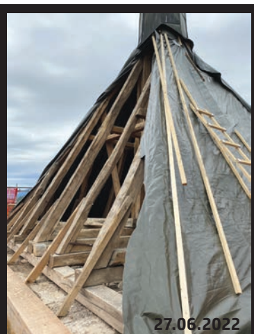
Le toit de la tour est en cours d'assainissement et recevra une nouvelle couverture. Par la même occasion, 48 nichoirs à martinets ont été installés en haut de cette tour.
