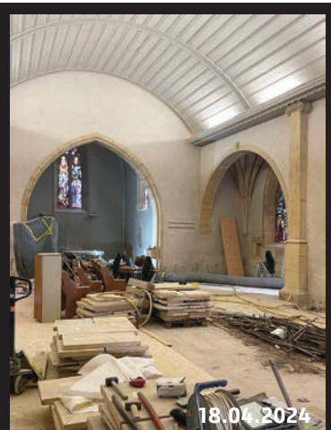
Le Temple a été vidé afin de permettre la réalisation des travaux intérieurs. Les dalles en pierre ont été déposées pour permettre la mise en place du nouveau chauffage. Elles seront adaptées et reposées par la suite.
