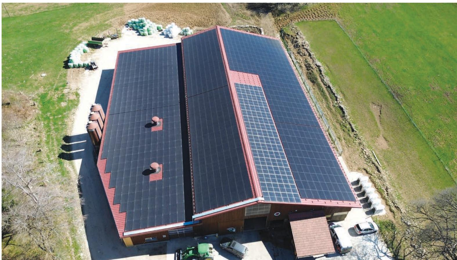
Le Carport solaire de Gottburg s'intègre à une installation de grande envergure sur toiture métallique. L'ensemble développe 432,9 kW de puissance grâce à 962 panneaux couvrant une surface de 1905 m<sup>2</sup>. Cette solution allie protection des véhicules et production d'électricité locale à haute valeur ajoutée. Elle illustre les solutions que Gottburg présentera au Salon de l'Immobilier Neuchâtelois. Pour en savoir davantage, rendez-vous page 7
